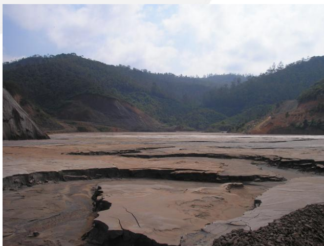
Fotografia 02: vista parcial do interior da Barragem do Fundão, onde se observa as áreas nas margens que deverão sofrer intervenção.
